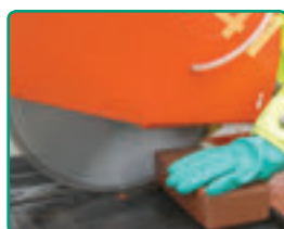
Przecinanie cegły przemysłowej
